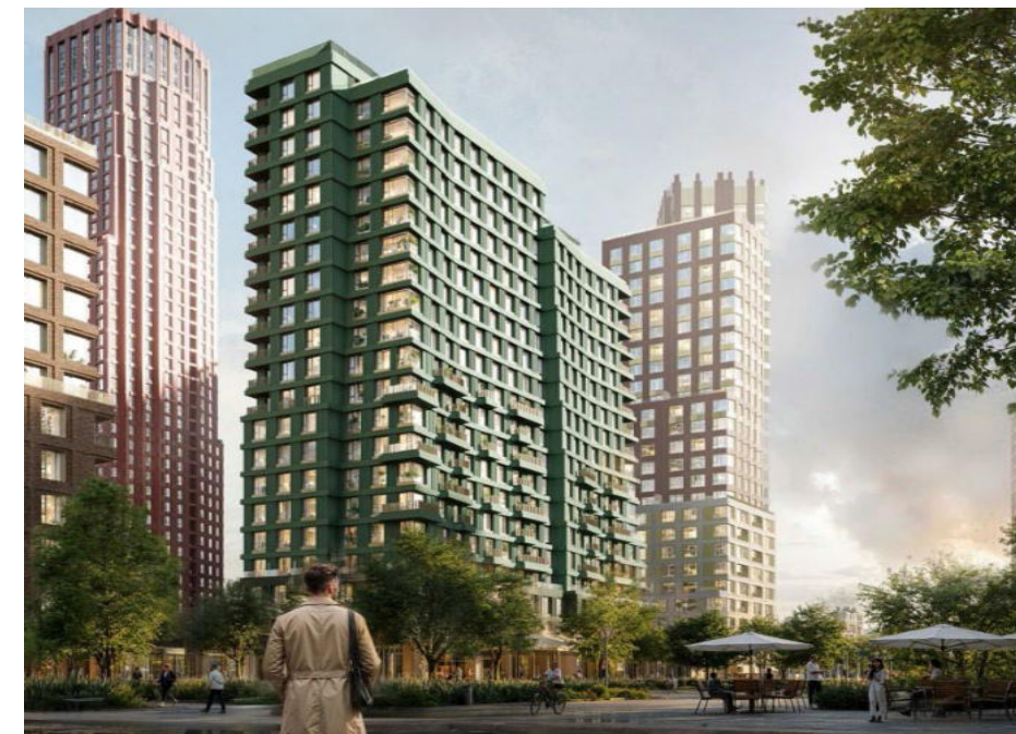
Многоквартирный жилой дом г. Москва, ЮАО, Москворечье-Сабурово, 1-й Варшавский пр-д, вл. 1а
