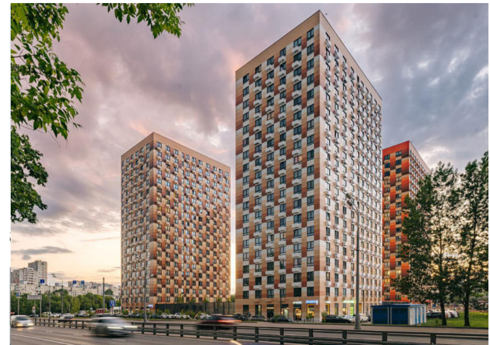
Многоквартирный жилой дом г. Москва, САО, ул. Большая Академическая, д.85
